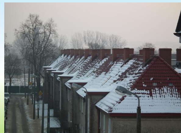
Ograniczenie niskiej emisji w Słupsku – podłączenie budynków mieszkalnych do miejskiej sieci ciepłowniczej
