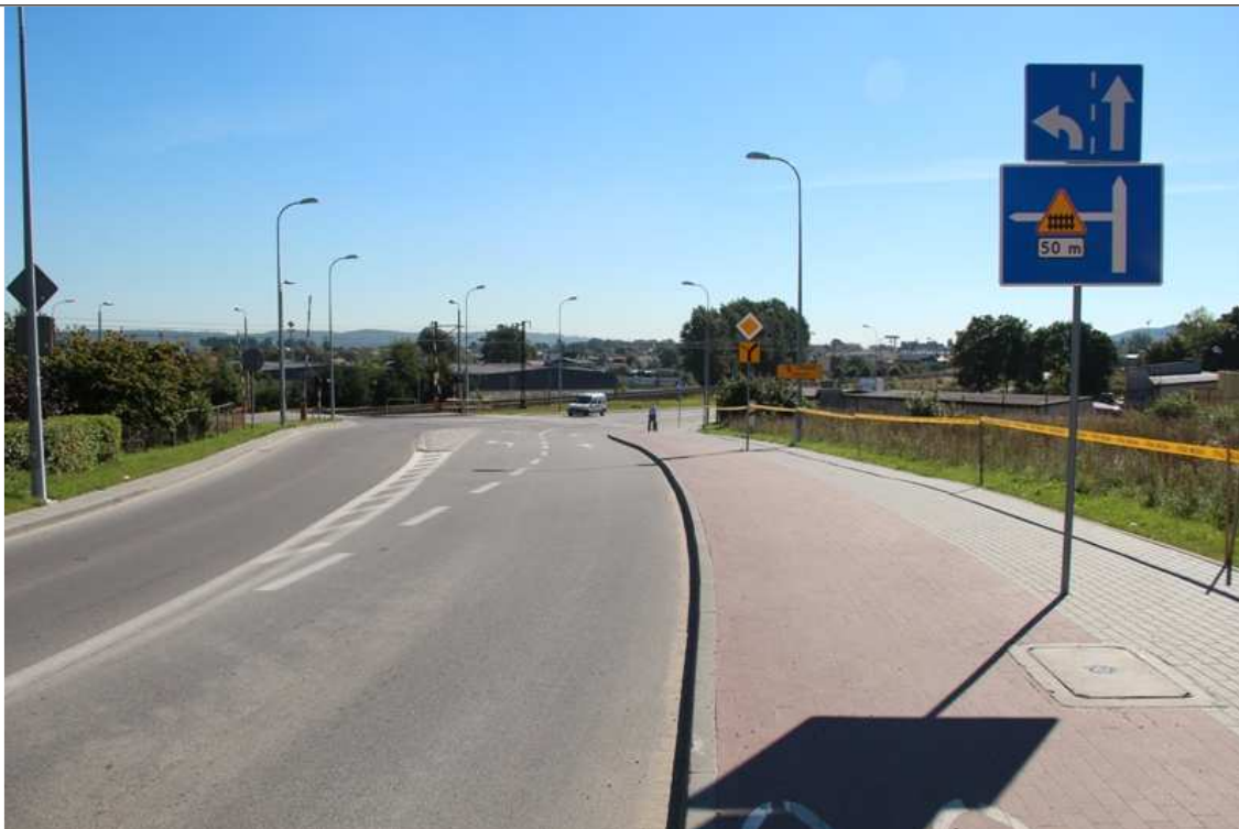
Rumia – skrzyżowanie ul. Cegielnianej z ul. Zbychowską
