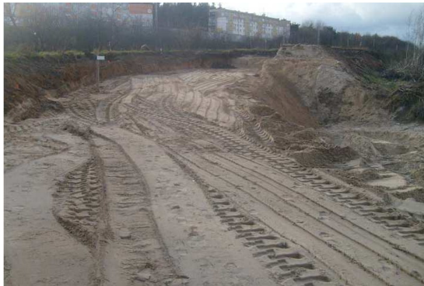
Zdjęcie 1. Ul. Drogowców w Redzie w trakcie przebudowy.
