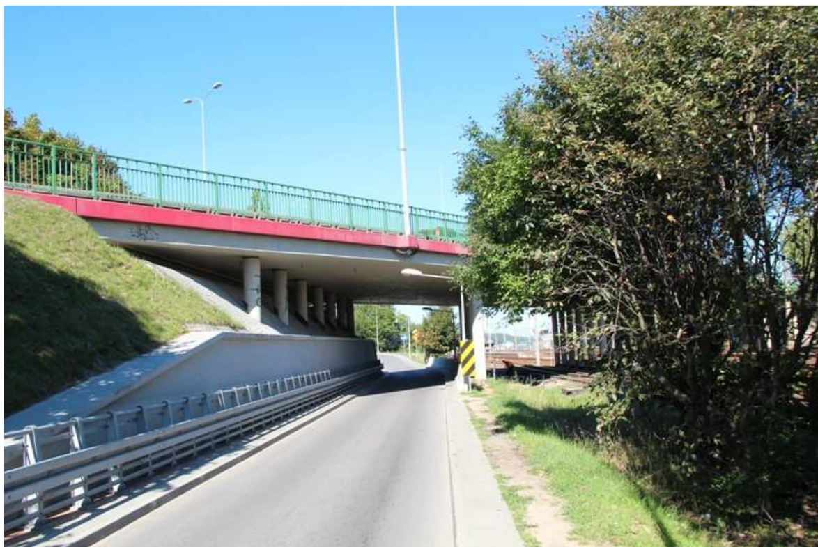
Rumia – zjazd z drogi krajowej nr 6 pod linią kolejową nr 202
