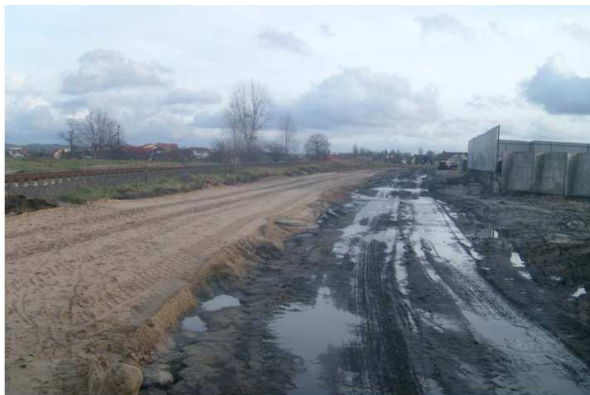
Zdjęcie 2. Ul. Drogowców w Redzie w trakcie przebudowy.
