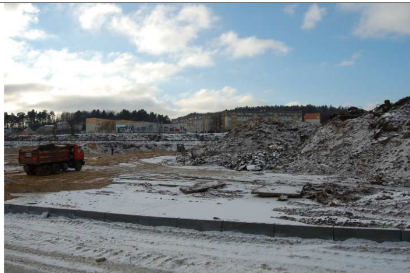
Zdjęcie 4. Ul. Drogowców w Redzie (widok na projektowany przejazd pod torami).
