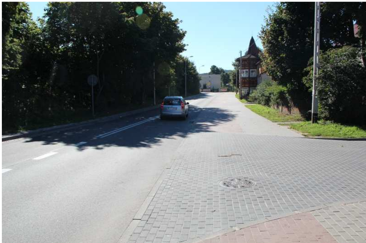
Rumia – ul. Towarowa, włączenie do drogi krajowej nr 6
