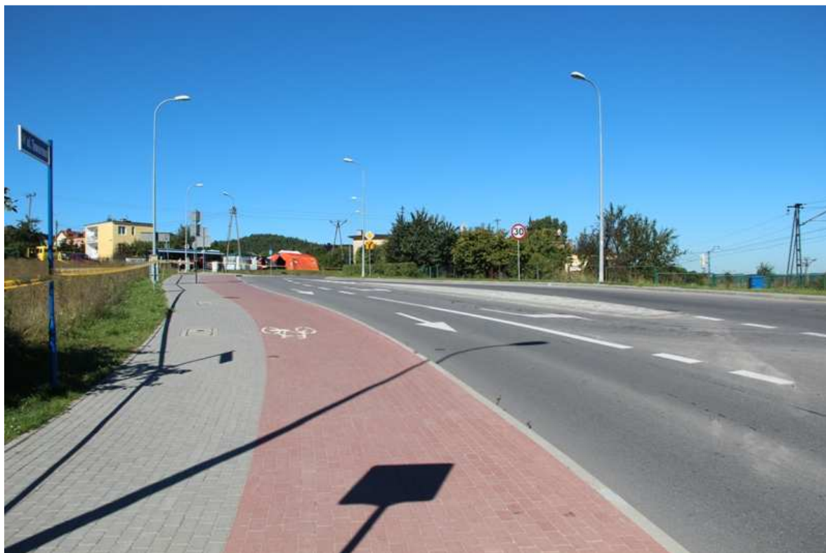
Rumia – ul. Cegielniana z ciągiem pieszym oraz ścieżką rowerową
