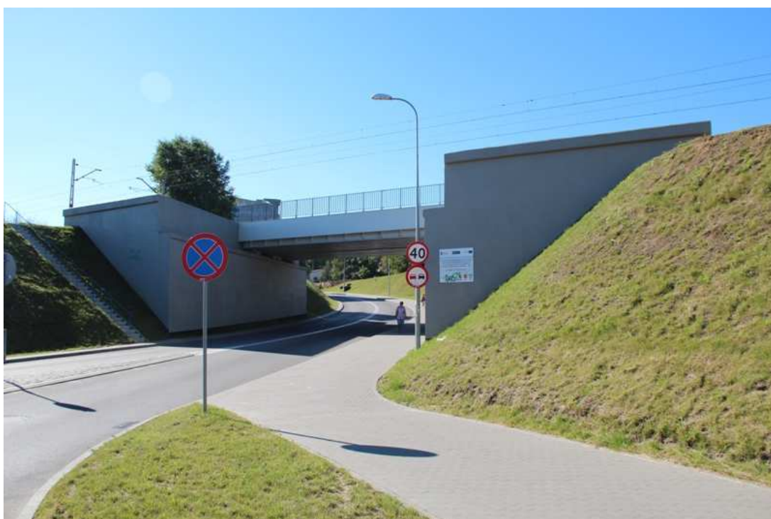
Reda – wiadukt nad ul. Drogowców w ciągu linii kolejowej nr 202
